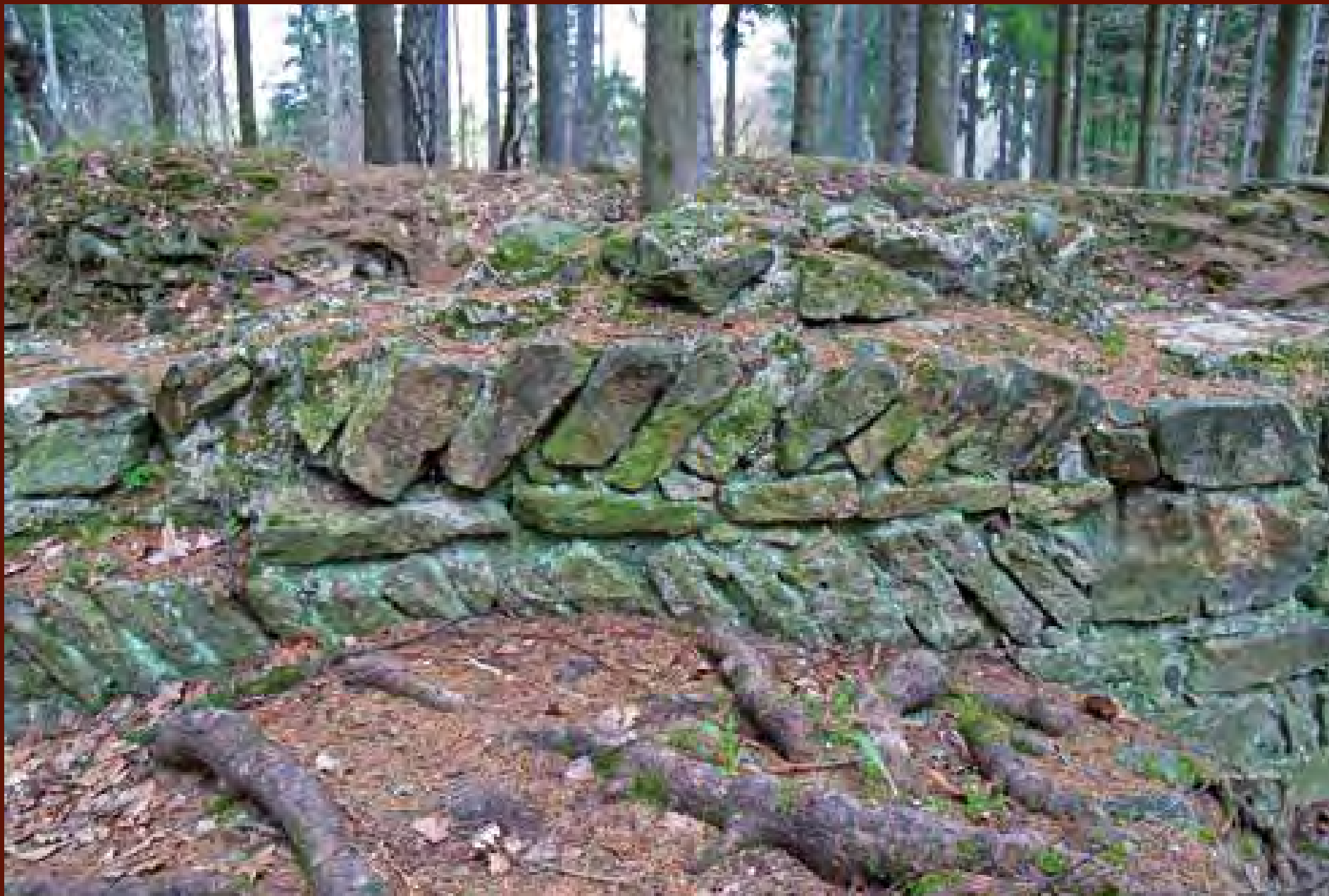
Vítkův Hrádek – část stěny paláce byla vystavěna starobylou stavební technikou označovanou jako opus spicatum (klasové zdivo), r. 2012 a nejstarší plán hradu z konce 19. století
